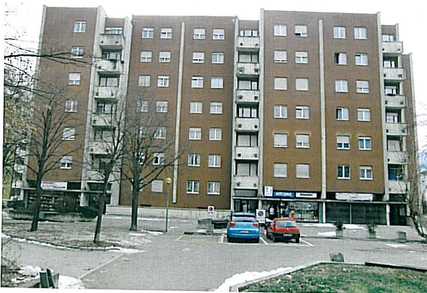
Nordansicht mit Vorplatz Prospetto nord con cortile esterno
