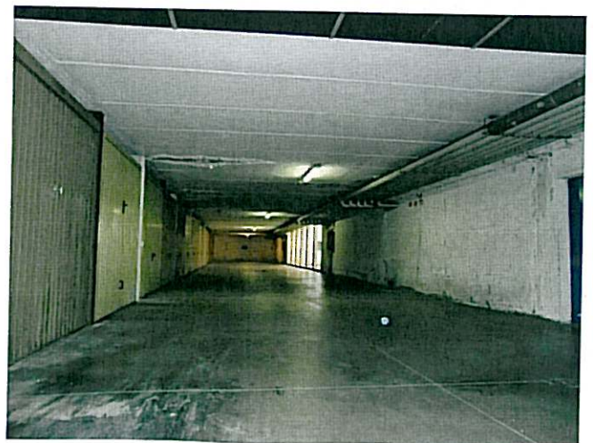
Fahrgasse Tiefgarage Corsia del garage interrato
