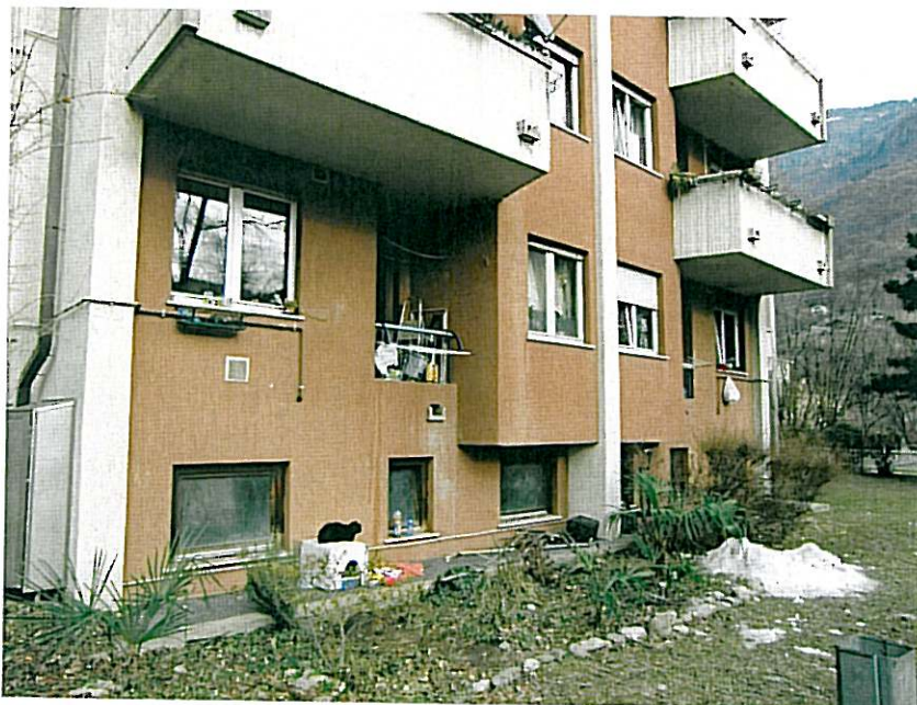
Balkone und Sockelbereich Gebäude Balconi e base dell'edificio
