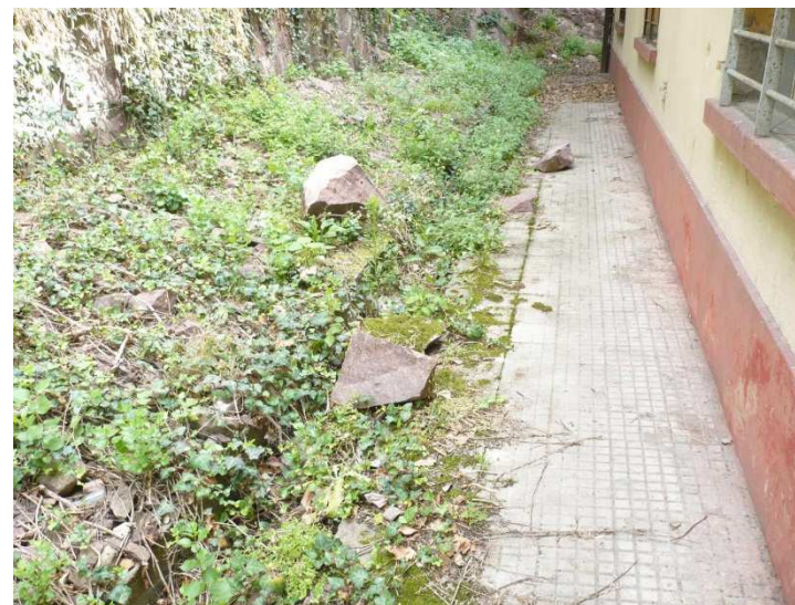
Evidenze di blocchi in posizione limitrofa ad Edificio 1
