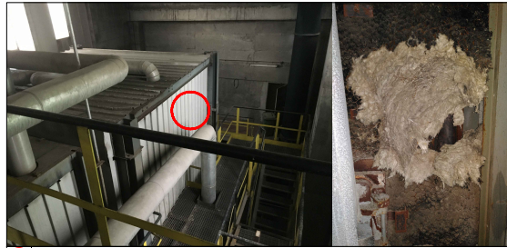
② SONDAGGIO 2 CALDAIA - LINEA 1
