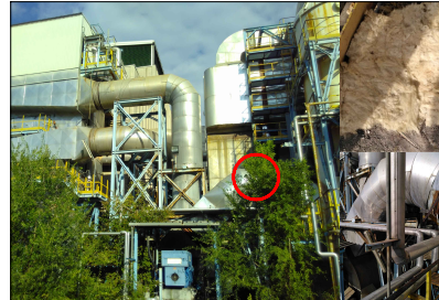
⑥ SONDAGGIO 6 TUBO DA VENTILATORE A TORRE ASSORBIMENTO - LINEA 2
