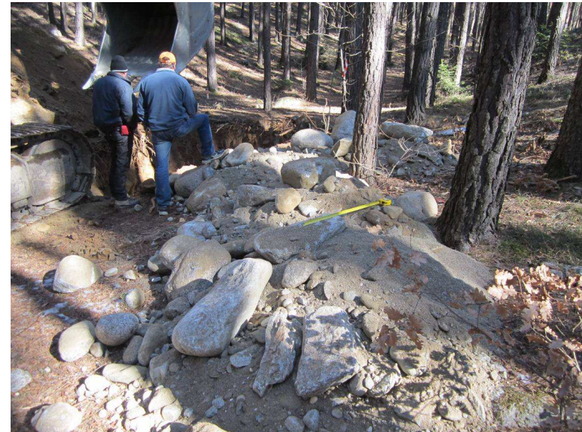
Material aus Baggerschurf 2: Zur Ermittlung der Großkörner.
